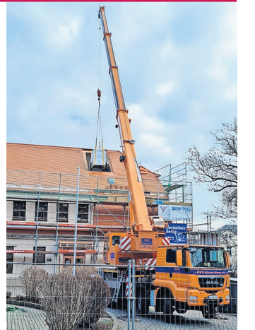
Echt spektakulär: Das Lüftungsgerät wurde durch das geöffnete Dach eingehoben. Foto: Pawletta
