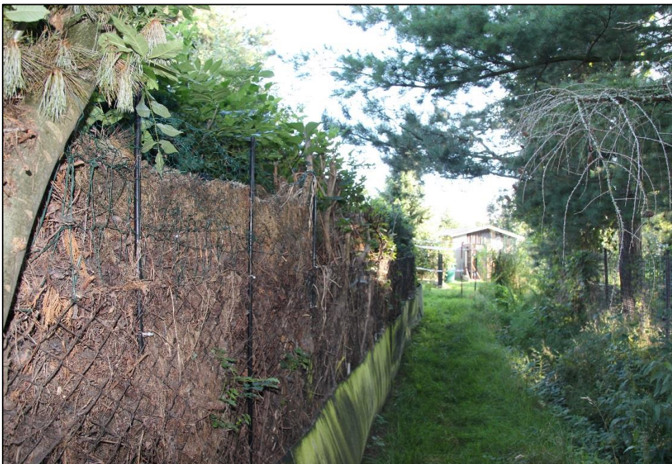
Bild 4: Entlang der östlichen Plangeietsgrenze verläuft ein Grünweg. In diesem Bereich ist die Ausweisung einer Fußwegfläche vorgesehen. [PLA.NET August 2016].
