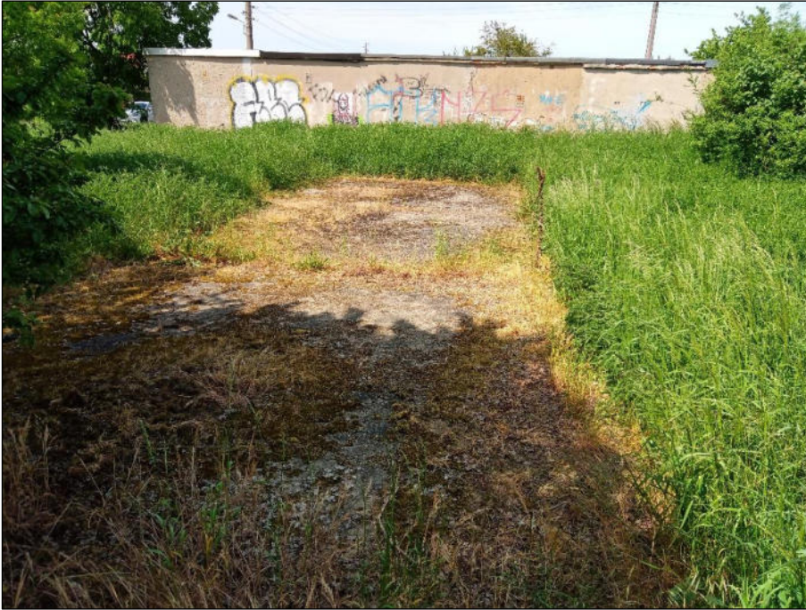
Bild 3: Betonfläche, welche zurückgebaut werden soll (22.05.2023).
