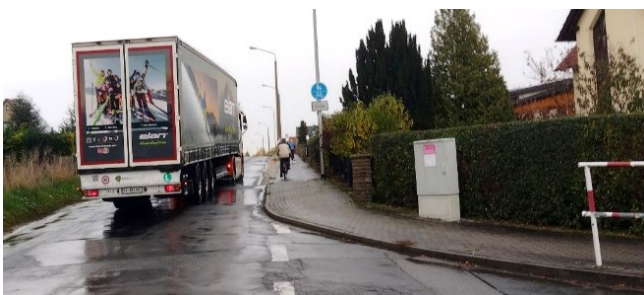
Abbildung 27: Hangstraße: einzige Verbindung zwischen Zschöllau und Merkwitz, gemeinsamer Geh- und Radweg endet ohne sichere Fortführung, Radweg beginnt erst wieder auf Höhe Einfahrt Matratzenfabrik, ungeschützter Seitenwechsel nötig
