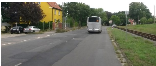
Abbildung 26: Bahnhofstraße (S 30): alternativlos zur Erschließung des Bahnhofs mit dem Fahrrad, Belag v. a. in Randbereichen mangelhaft, keine sichere Querung zum Radweg Dreibrückenweg vorhanden, Gefahren durch die Bedeutung als Nord-Süd-Achse für den Schwerverkehr.
