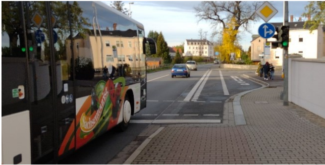
Abbildung 24: Dresdener Straße (B 6) Höhe Riesaer Straße: Radweg endet, Weiterführung als gemeinsamer Geh- und Radweg. Gefahr durch Bushaltestelle rechts der Radfart, Beginn des Zweirichtungsrads mit entsprechendem Querungsbedarf für in südlicher Richtung Radfahrende
