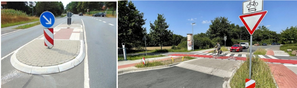
Abbildung 122: Beispiel für vorbildliche Querungsanlage, Quelle: pebueso.de
