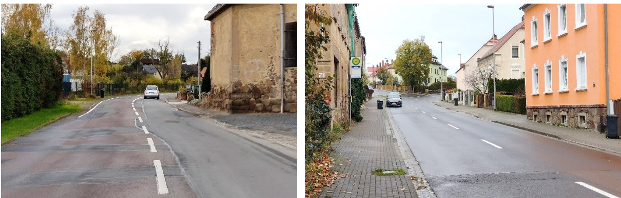
Abbildung 107 und 108: Auf der Thalheimer Straße in Altoschatz (links) und der Mühlberger Straße in Zschöllau (rechts) könnte die Entfernung der Mittelmarkierung die Sicherheit erhöhen.
