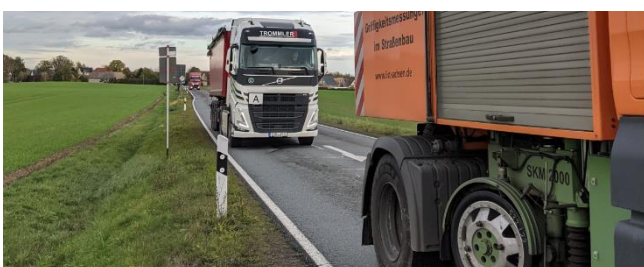
Abbildung 28: Ernst-Schneller-Straße (S 30): direkte Verbindung zwischen Lonnwitz und Naundorf, sehr hoher Schwerverkehrsanteil, besondere Gefahrenstellen in der Ortsdurchfahrt ohne Geh- und Radwege, Böschung und Graben direkt am Fahrbahnrand
