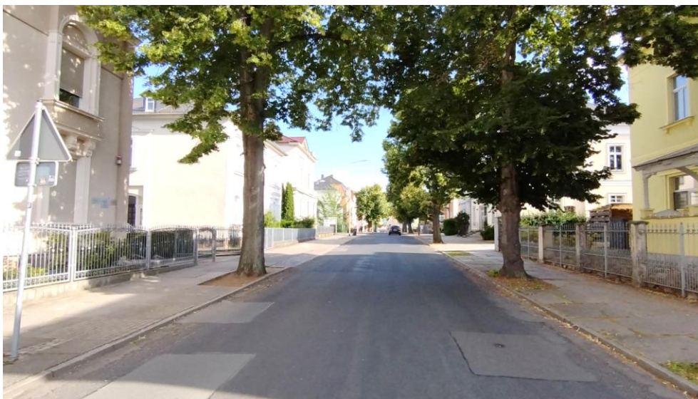
Abbildung 34: Lutherstraße: unverhältnismäßig breite Fahrbahn (ca. 7 m) und gerader Verlauf verleiten Kfz zum Rasen, keine Verkehrsberuhigung durch Tempo 30
