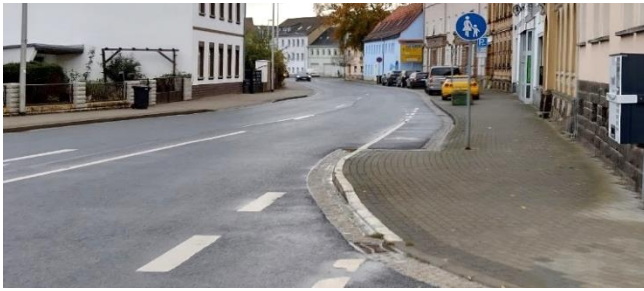
Abbildung 23: Wermsdorfer Straße (S 38): gefährliche Überführung in Mischverkehr, hoher Schwerverkehrsanteil, potenziell ausreichend Platz für RVA bei Entnahme des Kfz-Parkens
