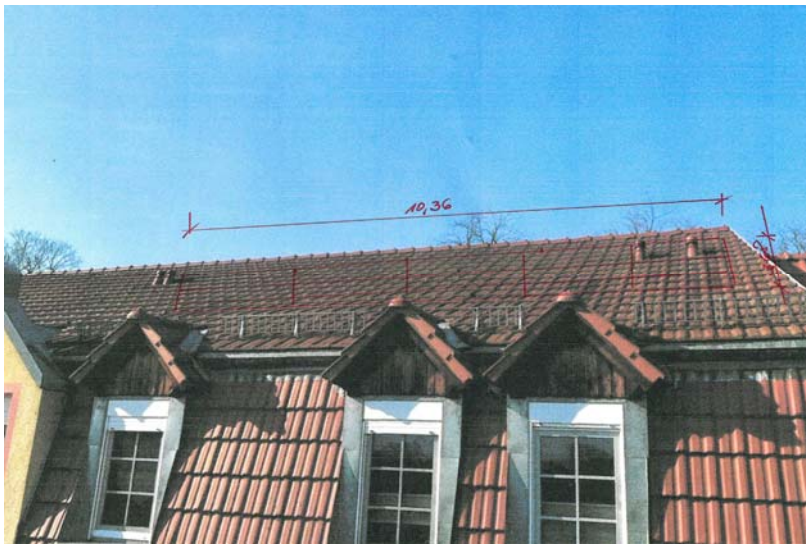
Lage im Dach von Webergasse aus
