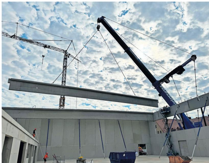
An einem Spezialkran schweben sie ein, die neun Spannbetonbinder für die neue Turnhalle in der Bahnhofstraße.
