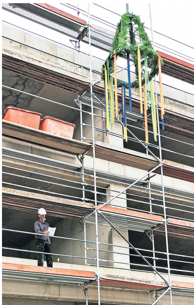
Mit dem Verlesen des Richtspruchs wurde der Rohbau des Gebäudes geweiht.
