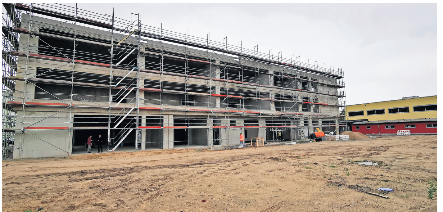
Zum Richtfest wurden die Dimensionen der neuen Grundschule mit Hort auf jeden Fall deutlich: Bis zum Beginn des Schuljahres 2025/2026 soll das Gebäude fertiggestellt sein. Fotos: Stadt Oschatz
