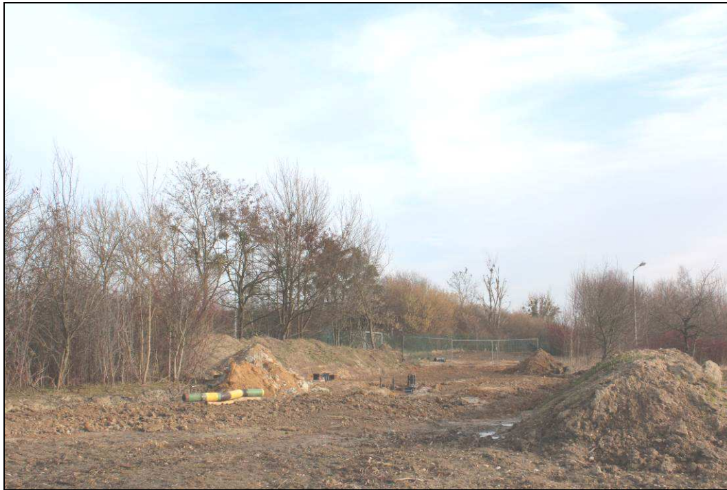
Bild 1: Das Foto zeigt den Blick auf die Baustelle im Westen des Plangebietes (Februar 2015).
