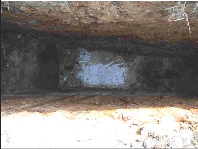
Abb. 4 Industriegebiet "Fliegerhorst" Oschatz Grundwasserstand in Schürfgrube (5,5 m tief)
