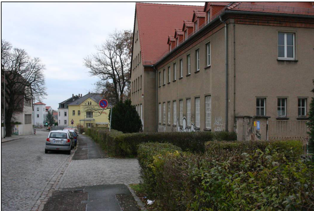
Blick entlang des Bahnhofstraße im Norden des Plangebietes; rechter Hand das alte Postgebäude; November 2012
