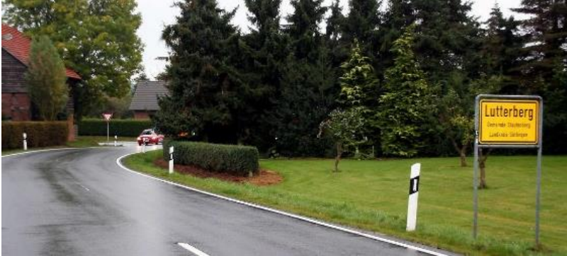
Abbildung 106: Beispiel für eine entfernte Mittelmarkierung ab Ortseingang in Lutterberg, Niedersachsen
