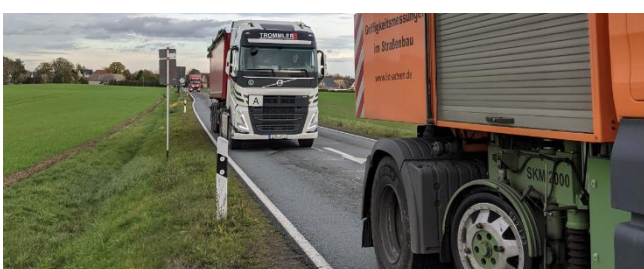
Abbildung 28: Ernst-Schneller-Straße (S 30): direkte Verbindung zwischen Lonnwitz und Naundorf, sehr hoher Schwerverkehrsanteil, besondere Gefahrenstellen in der Ortsdurchfahrt ohne Geh- und Radwege, Böschung und Graben direkt am Fahrbahnrand
