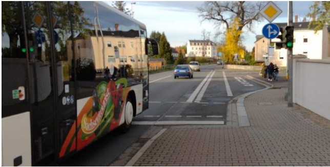
Abbildung 24: Dresdener Straße (B 6) Höhe Riesaer Straße: Radweg endet, Weiterführung als gemeinsamer Geh- und Radweg. Gefahr durch Bushaltestelle rechts der Radfart, Beginn des Zweirichtungsrads mit entsprechendem Querungsbedarf für in südlicher Richtung Radfahrende
