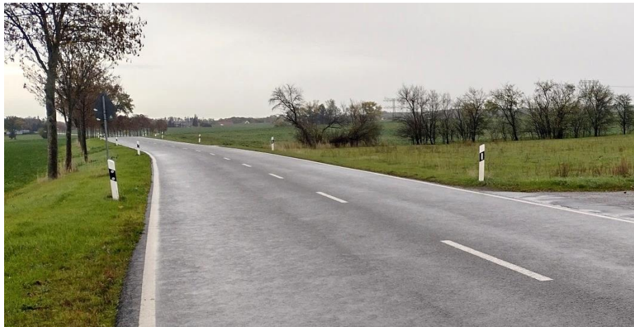
Abbildung 80: S 30 zwischen Merkwitz und Wellerswalde
