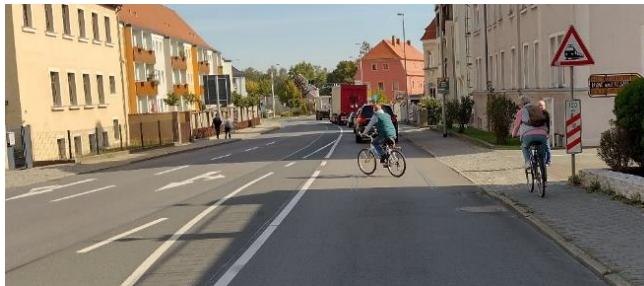
Abbildung 25: Promenade (B 6): zu schmaler gemeinsamer Geh- und Radweg, unklare Führung an Knoten, keine RVA auf der nördlichen Straßenseite
