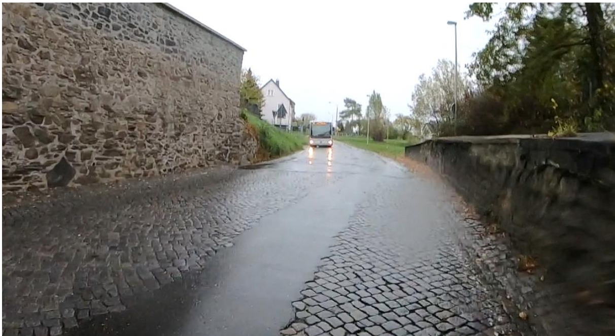
Abbildung 89: Der enge Bereich der Hangstraße (S 30) beim Friedhof sollte dringend zusätzlich zum bereits ausgewiesenen Tempolimit 30 durch weitere Maßnahmen wie Piktogrammketten gekennzeichnet oder beruhigt werden. Der sehr schmale, unbefestigte Gehweg ist für Fahrräder nicht benutzbar (und selbst für Zufußgehende, bspw. mit Kinderwagen, ein beschwerlicher bis unmöglicher Weg). Bus- und Schwerverkehr, Steigung, mangelhafter Belag sind hier zusätzliche kumulierte Gefahrenquellen.
