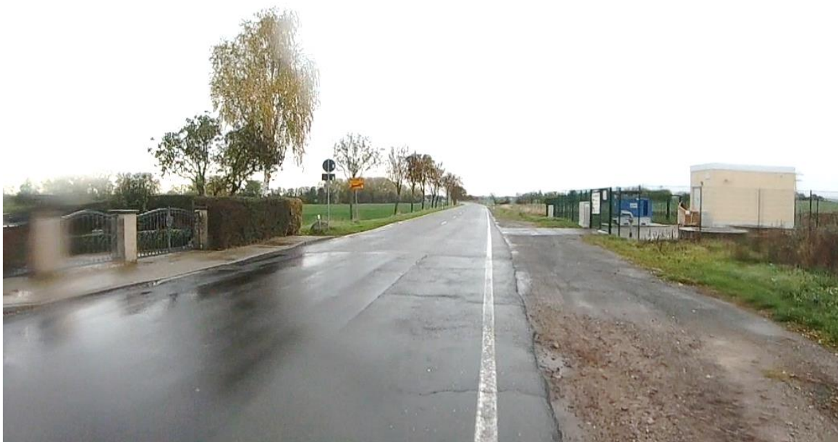
Abbildung 132: Ortseingang Merkwitz (S 30) mit Potenzial für eine Verkehrsinsel (und Bedarf für einen straßenbegleitenden Radweg)
