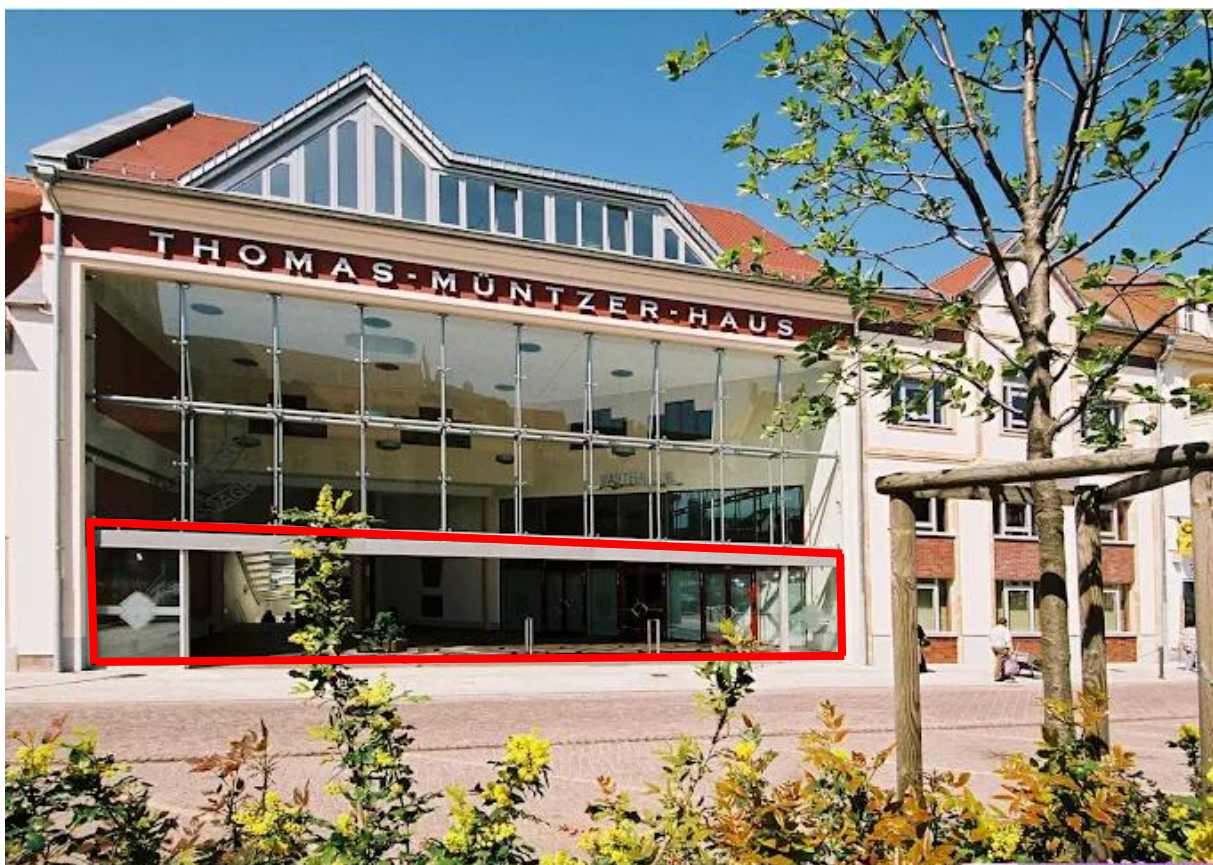
Bereich Sanierung Glasfassade
